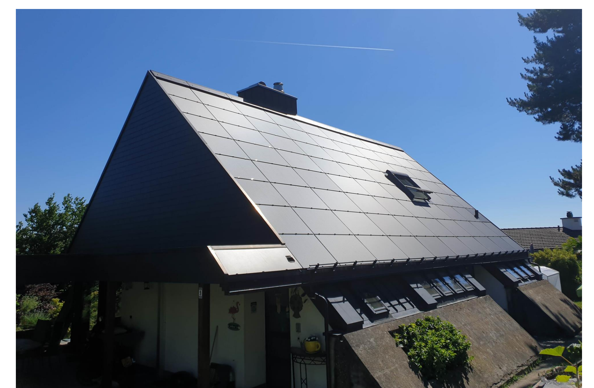
Abbildung 6: Dachfläche nach der Sanierung
