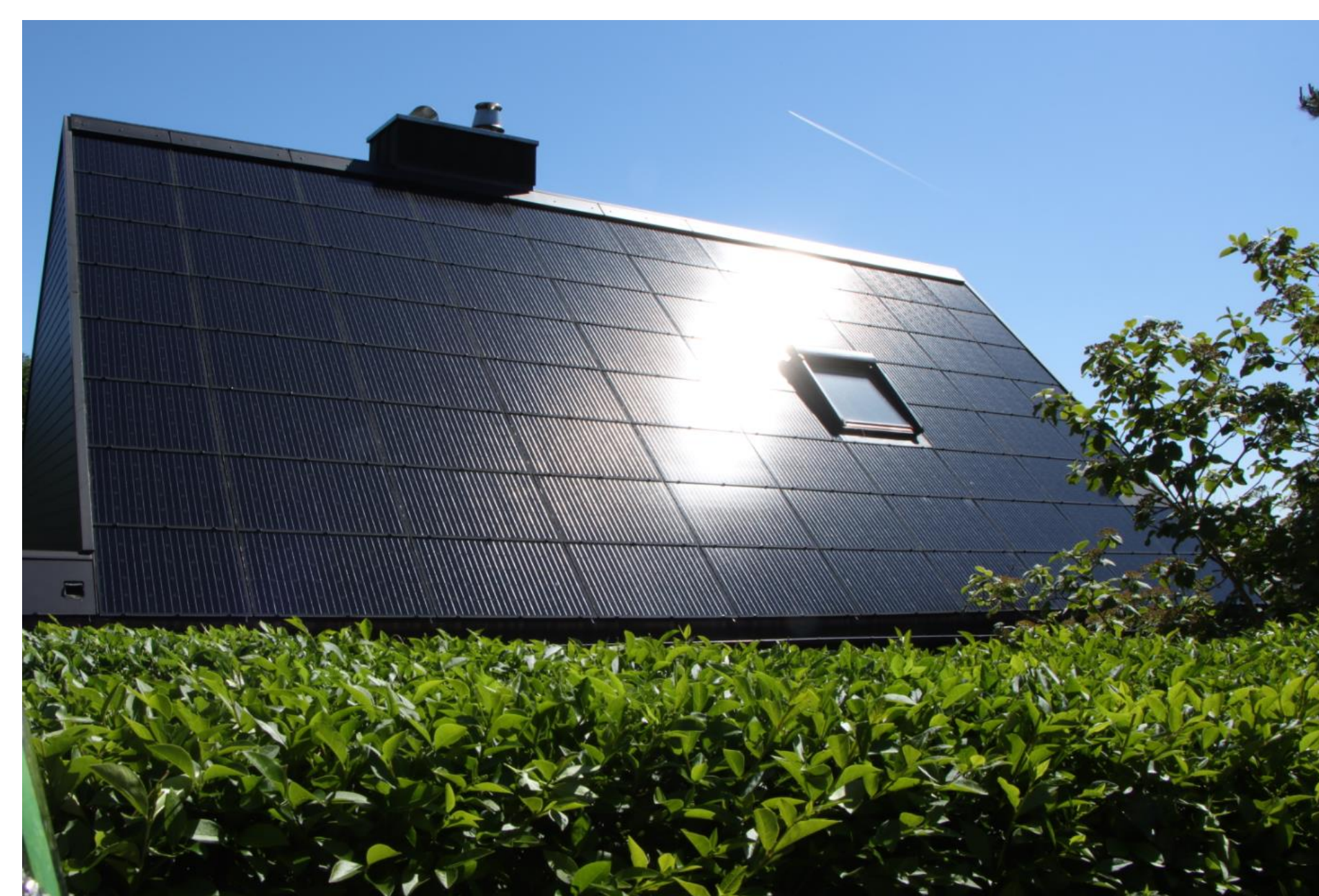
Abbildung 4: Dachfläche vor der Sanierung
