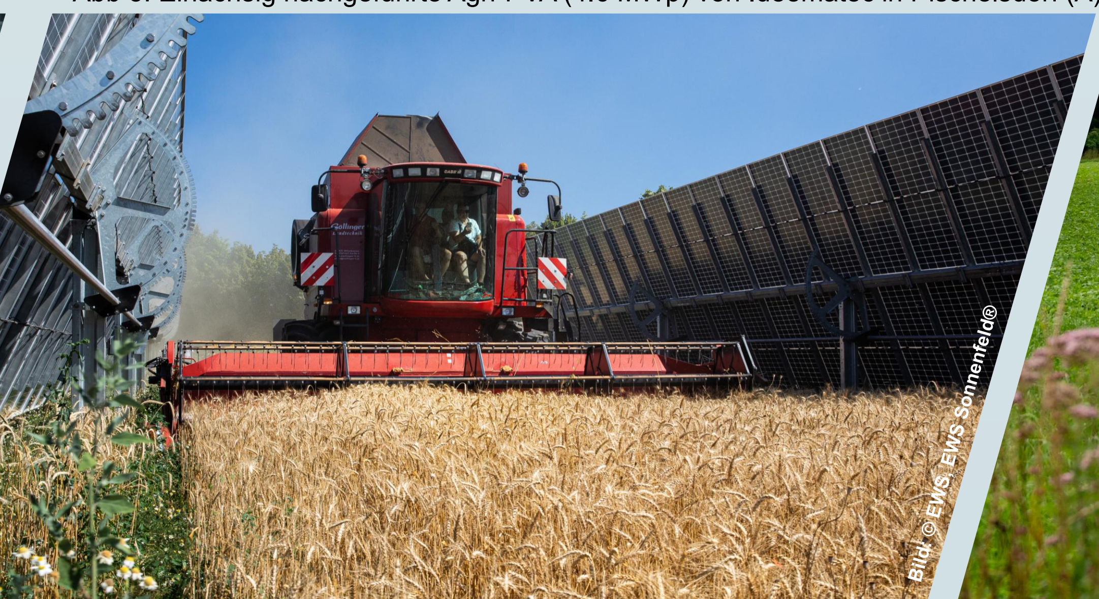
Abb 5: Einachsig nachgeführte Agri-PVA (4.6 MWp) von Ideematec in Pischelsdorf (A)
