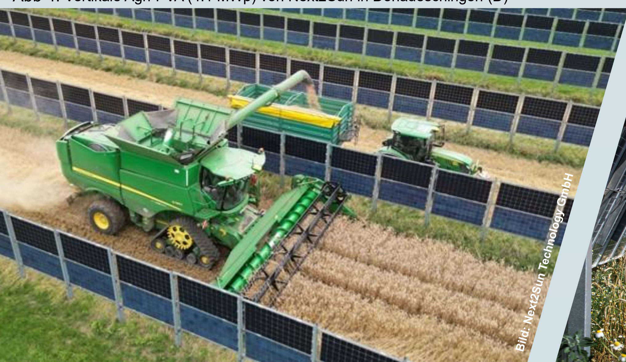
Abb 4: Vertikale Agri-PVA (4.1 MWp) von Next2Sun in Donaueschingen (D)
